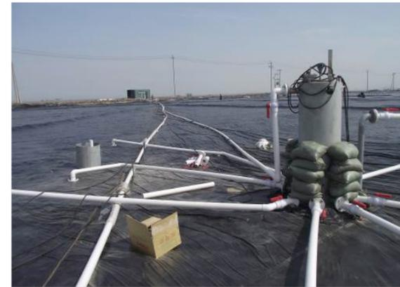
水汽分离罐与集中控制室及出膜装置连接
