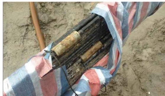
图6 QJEM20 索力传感器安装图
