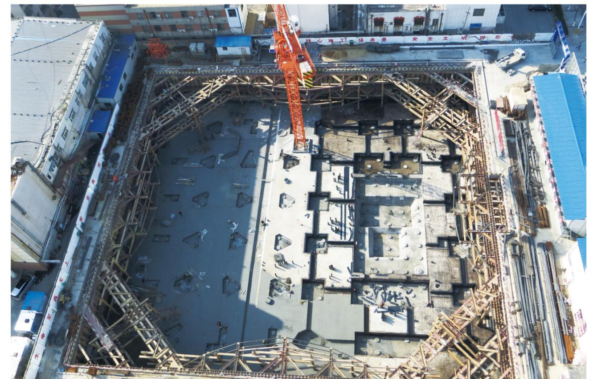
开挖深度：11.5m 开挖面积：7000m<sup>2</sup>
