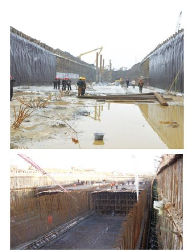
(3) 深厚淤泥质土的变形控制，开挖深度17m，开挖面积42000m<sup>2</sup>。
