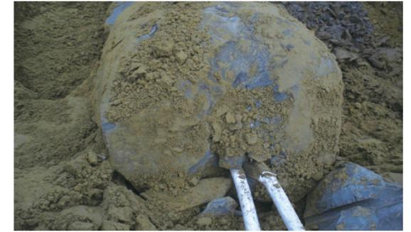
旋喷搅拌加劲桩的成桩形态揭示
