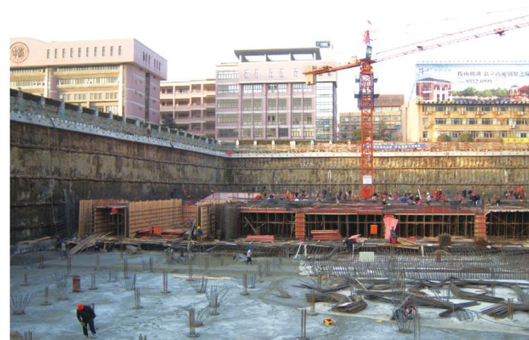
(2) 在高水位的粉土、粉砂土层的深基坑支护，开挖深度15m，解决了开孔后漏水与喷砂难题
