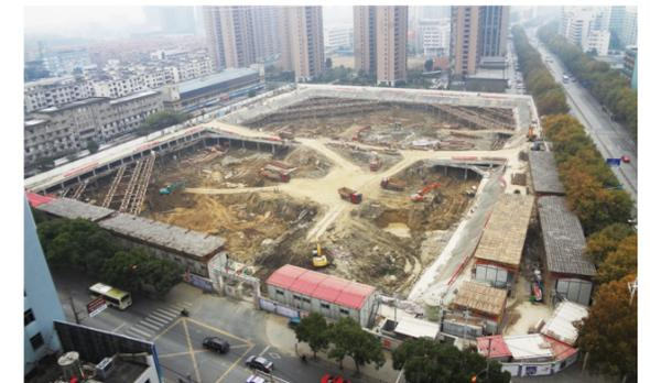
开挖深度：15m 开挖面积：30000m<sup>2</sup>
