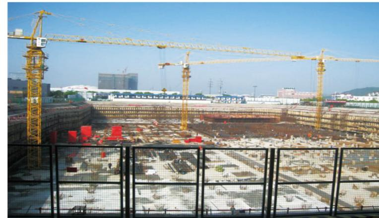
(1) 软土深基坑支护，开挖深度16~24m，开挖面积40000m<sup>2</sup>。
