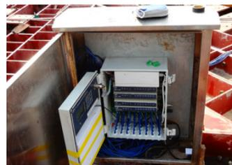
图2 数据采集与通信装置安装图
